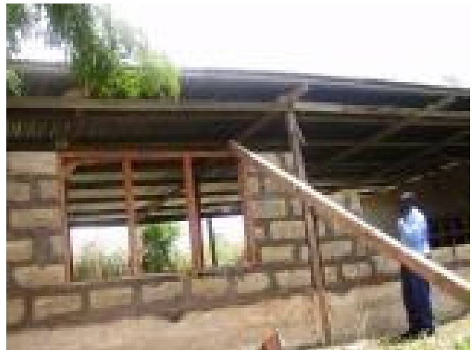
Der Schlafrum 2 wird gebaut
