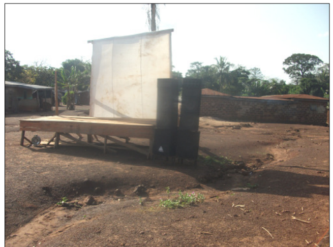
Die erste Arbeit in jedem Dorf: Eine Plattform bauen für Sprecher, Technik und Beleuchtung
